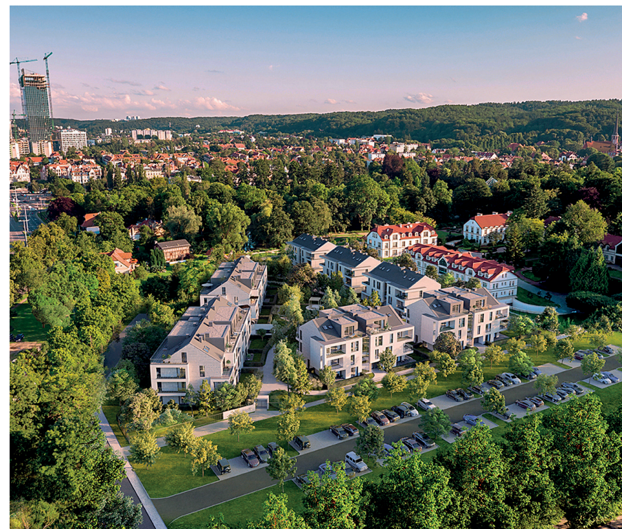
ŁĄCZNIE W OSIEDLU OLIEWSKI PARK POWSTANĄ 102 MIESZKANIA I APARTAMENTY O POWIERZCHNI OD 47 DO 142 M KW. BUDOWA RUSZY NA POCZĄTKU WRZEŚNIA BR. I POTRWA OKOŁO 20 MIESIĘCY.
