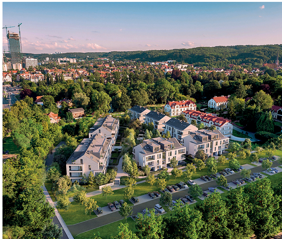
ŁĄCZNIE W OSIEDLU OLIWSKI PARK POWSTANĄ 102 MIESZKANIA I APARTAMENTY O POWIERZCHNI OD 47 DO 142 M KW. BUDOWA RUSZY NA POCZĄTKU WRZEŚNIA BR. I POTRWA OKOŁO 20 MIESIĘCY.
